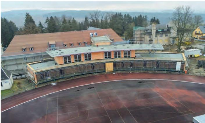
Im Altbau sind wesentliche Arbeiten am Bestand sichtbar. Der Dachausbau im Bürgerhaus wurde abgeschlossen und die Gewerke für Heizung, Lüftung, Sanitär sowie die Elektroinstallation und Trockenbauarbeiten befinden sich in der Ausführung. Die Putzarbeiten an Innen- und Außenflächen sind bereits weit fortgeschritten. Die Fensterfronten sind vollständig montiert, und derzeit erfolgt der Einbau der Türen.
