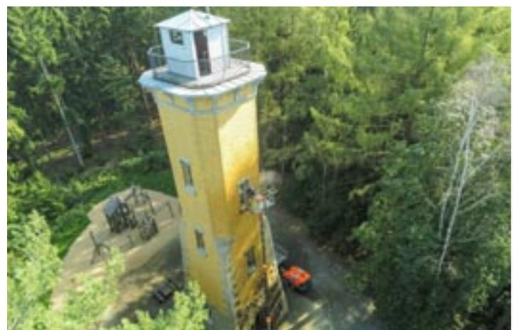
Der Perlaser Turm erstrahlt nach einer gründlichen Reinigung in neuem Glanz. In den letzten Wochen hat der Kommunalstützpunkt der Stadt Treuen die Außenfassade des Turms mit einem Hochdruckreiniger gründlich gereinigt. Als nächster Schritt wird der Granitsockel demnächst neu verfugt. Foto: pko
