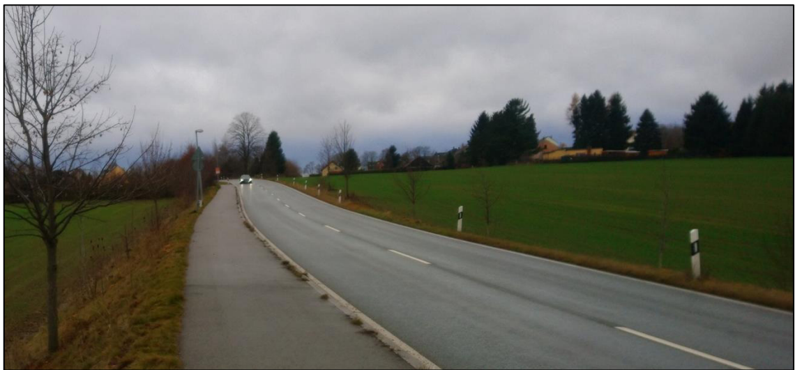
Abb. 4: Bestandssituation Perlaser Straße (S 298)
