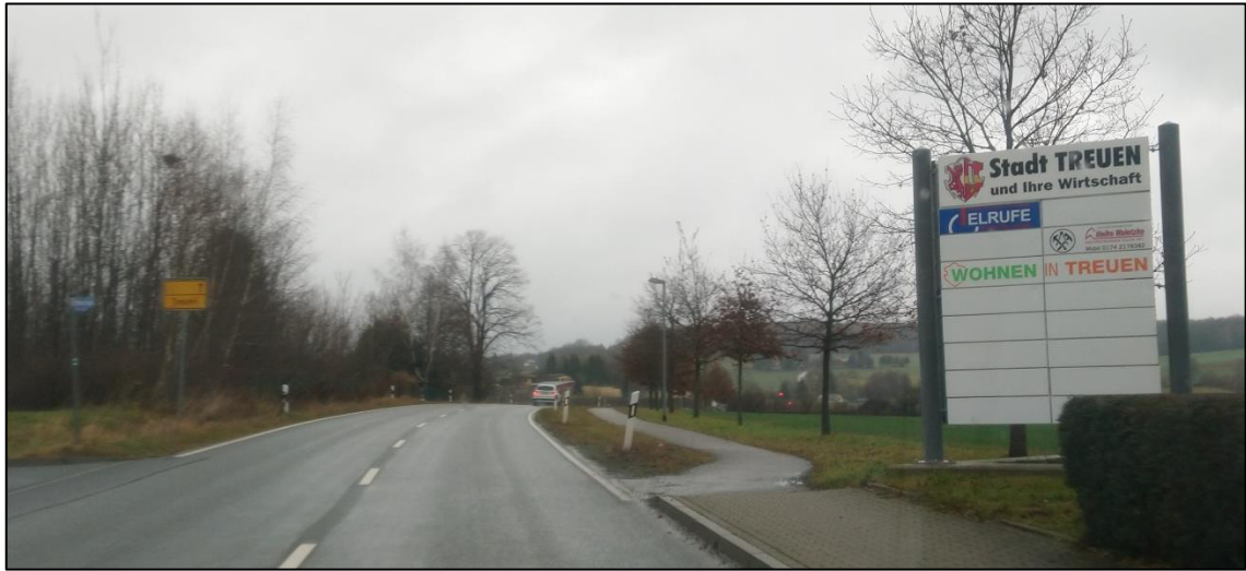
Abb. 3: Bestandssituation Perlaser Straße (S 298)
