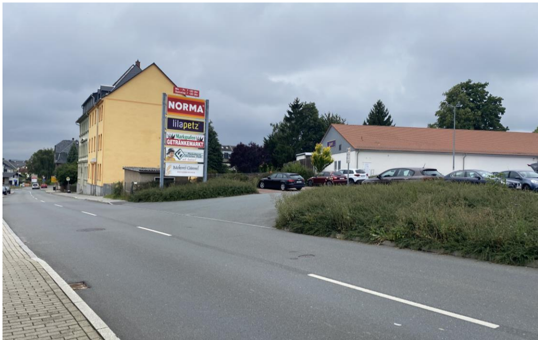
Abbildung 3: Die Perlaser Straße nahe dem Vorhabenareal mit Blick in Richtung Kreisverkehr
